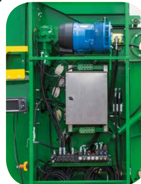
Steuerung 24 Volt-CAN-Bus Kompressor
